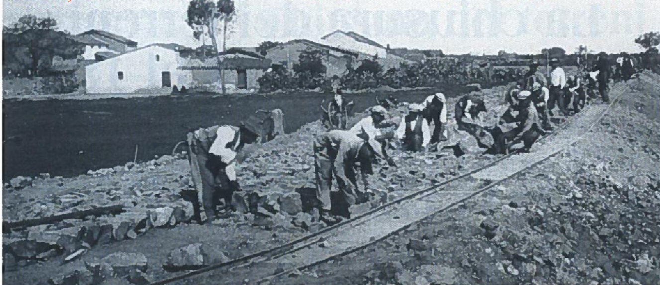
Operai al lavoro per costruire la strada all'altezza dell'incrocio tra via Porcella e via Marceddi
